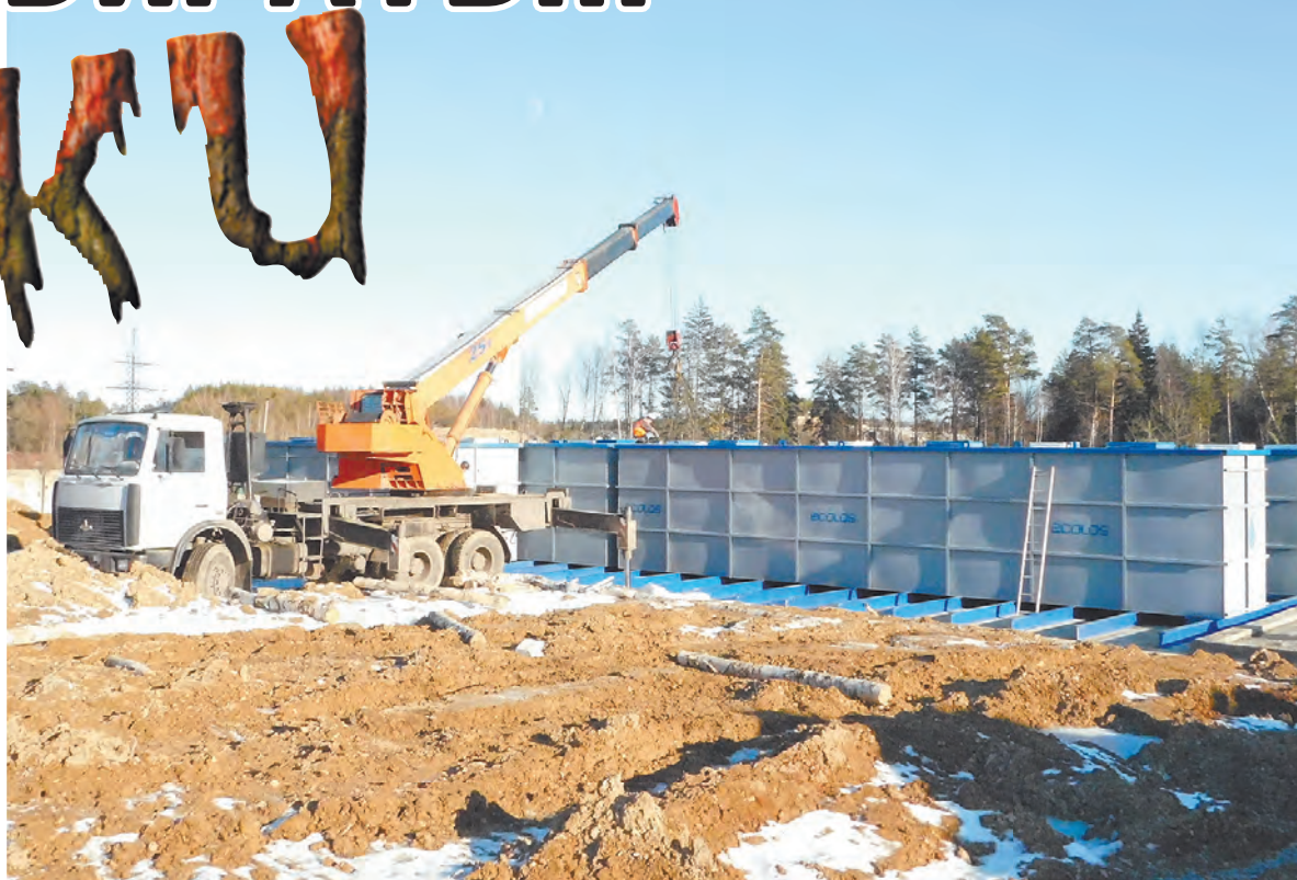
Жилетово. Установка емкостей для биоочистки.
