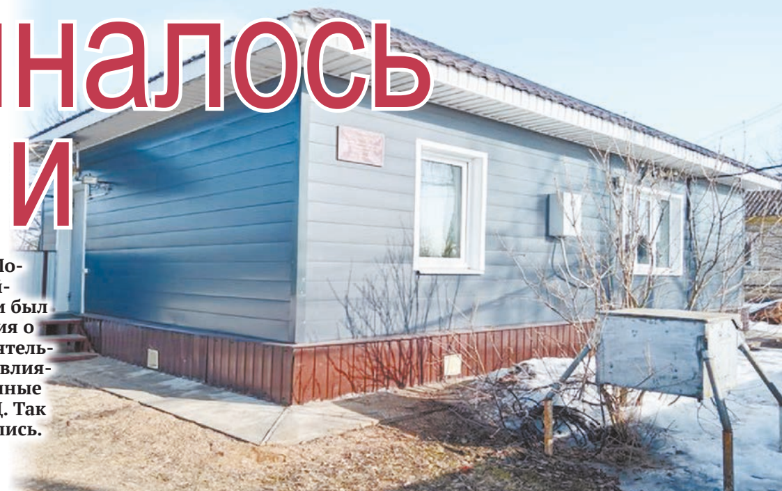
Служебное помещение метеостанции.
