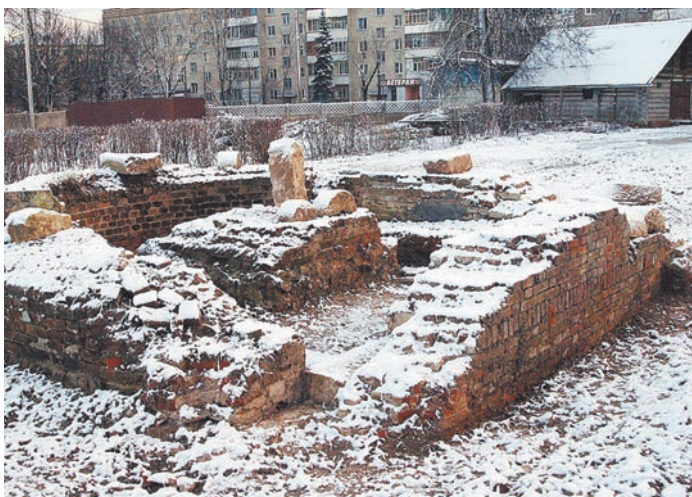
Начинается расчистка площадки для восстановления монастыря.
