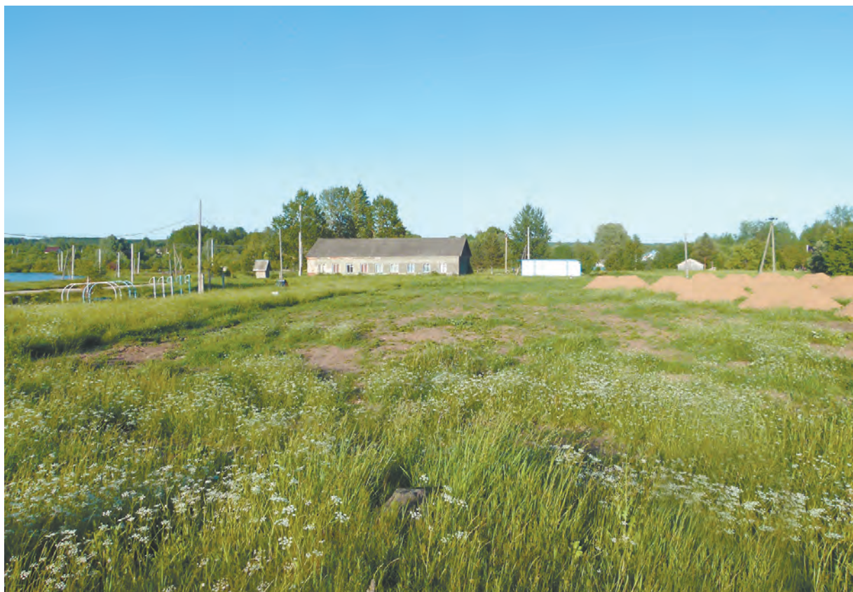
Территория будущей площадки, начало строительства.
