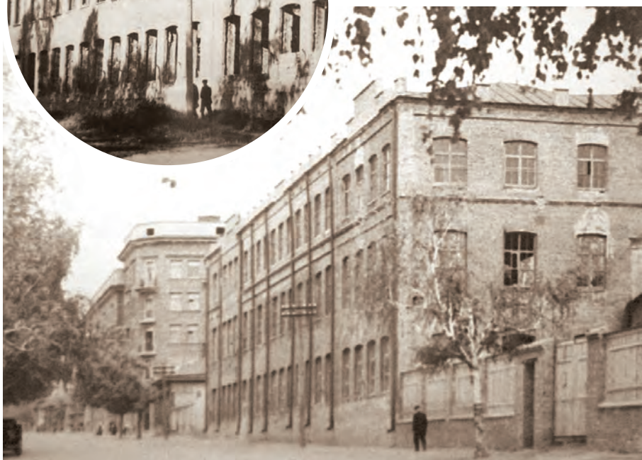
Восстановленная швейная фабрика.
